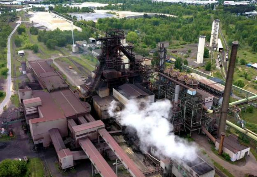
Das Projekt von ArcelorMittal zur Erdgaseinblasung in den Hochofen HO5A in Kooperation mit NOPA zielte auf eine verbesserte CO<sub>2</sub>-Bilanz ab. Durch die Installation einer Anlage zur kontrollierten Erdgaseinblasung wurden signifikante CO<sub>2</sub>-Einsparungen erreicht. NOPA trug durch Optimierung der Armaturen, Verringerung der Rohrdurchmesser und Armaturenanzahl zu erheblichen Kosteneinsparungen bei.
